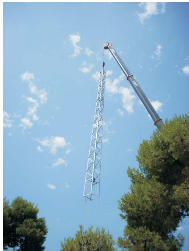
Instal·lació dels suports metàl·lics.
